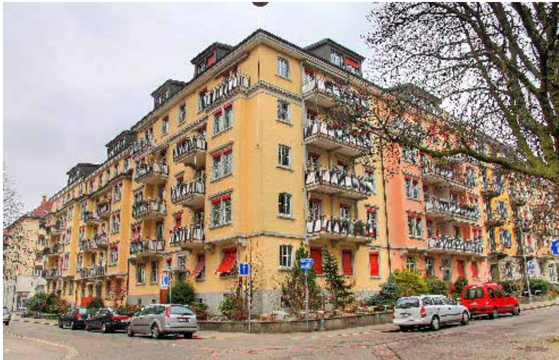
Le type de bâtiments locatifs intégrant désormais le programme officialisé de l'OFEV. COPYRIGHT ENERGO2016
